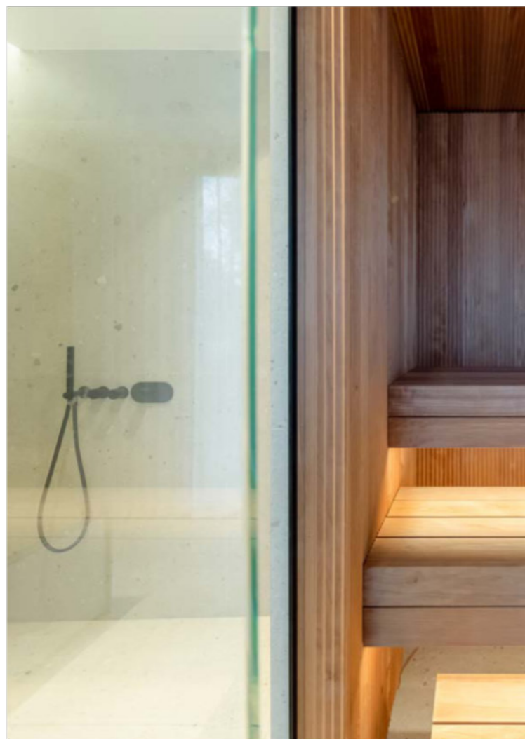
Tường và trần: Vire 15x69 gỗ dương lá rung biến tính nhiệt, ghế dài: SHP 15x90 gỗ dương lá rung biến tính nhiệt. Nhà riêng, Estonia. Ảnh: Elvo Jakobson
