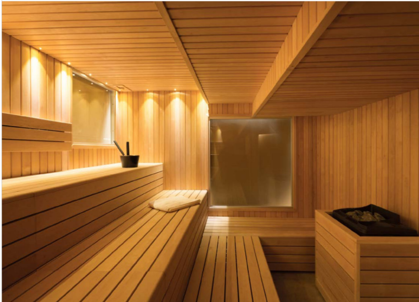
Tường: STP 15x90 gỗ trần, ghế dài: SHP 28x90 gỗ trần. Spa xông hơi khô tại Đức.
