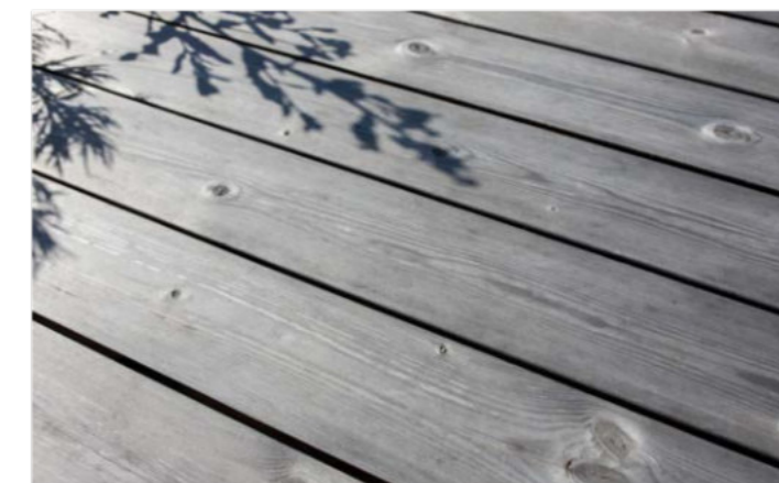
Thermory Benchmark sàn gỗ thông biến tính nhiệt, lão hóa và không phủ dầu.
